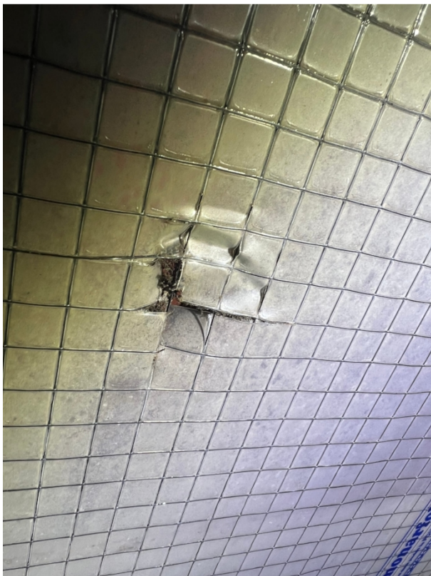
Undertaget fremstår enkelte steder med små huller
