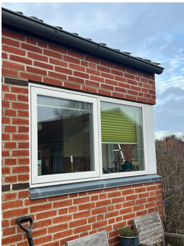
Vinduer er overvejende udført i træ/alu.
